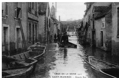
Rue Grande inondée
