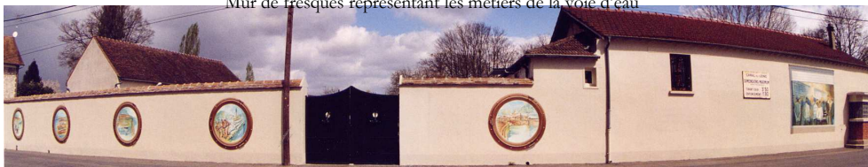
Mur de fresques représentant les métiers de la voie d'eau
